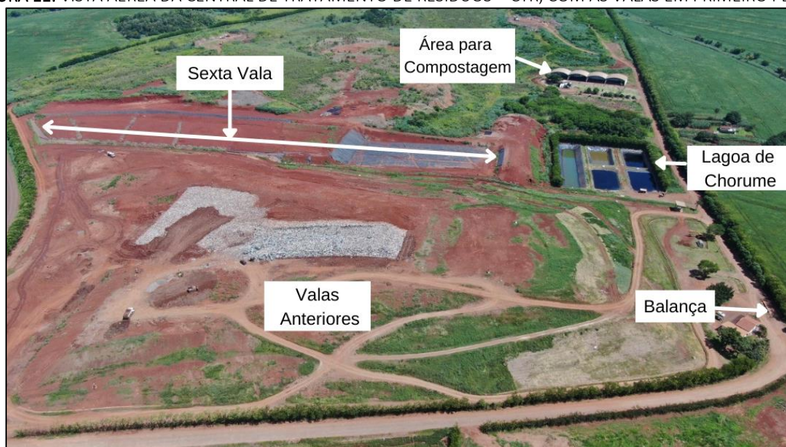
FIGURA 11: VISTA AÉREA DA CENTRAL DE TRATAMENTO DE RESÍDUOS – CTR, COM AS VALAS EM PRIMEIRO PLANO.
